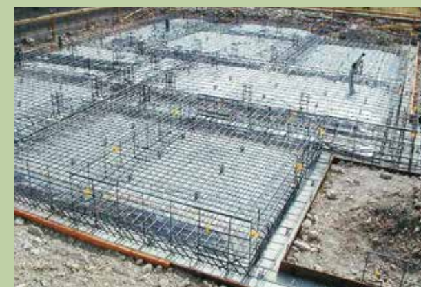
構造計算により配置される鉄筋
