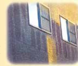
※構造体から逃げる熱でその部分だけに霜が積った状態。
