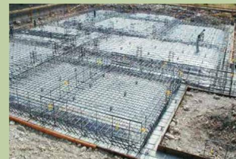
構造計算により配置される鉄筋
