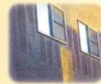
※構造体から逃げる熱でその部分だけに霜が積った状態。
